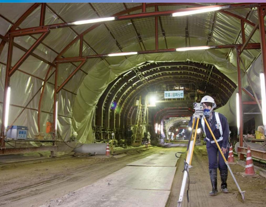
▲測量をして正確な位置を出して図面に書き込む。「トンネルはどのぐらいの交通量があるのか、仕様用途などで形も設計も変わってきます。同じものがないのも面白いところです」。
