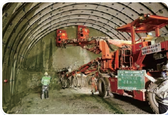
マンゲージプロテクターの設置
