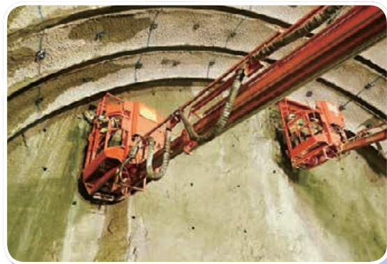
マンゲージプロテクターの設置
