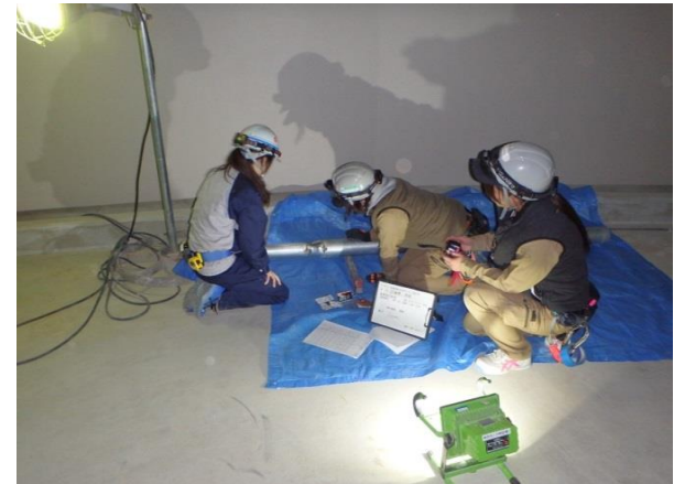
施工者自主検査状況
