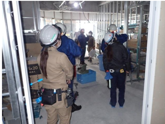
消防検査の立会い
