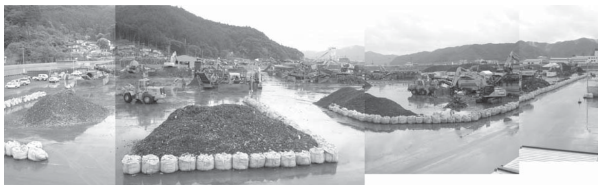
写真一3 大槌地区二次仮置き場状況 (破碎/選別ヤード全景)
