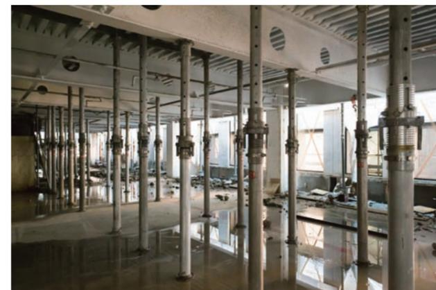
上／昇降ジブクレーンシステムにおけるジャッキ柱。各柱に1人ずつ作業員がつき、水平を確認しながら、慎重にジャッキダウンが行われている。下／解体が進む下階の様子。φ100mmの仮設柱が1m四方に並べられている。
