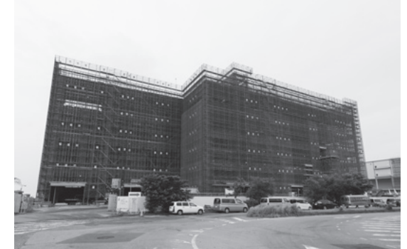
上／左から、(株)田中建設工業・筑井職長、前川、五洋建設(株)・菊谷工事所長。「高校を出て、女性が少ない職場で3年も続いている。職長さんのサポートあってのものだと思います」(菊谷工事所長) 下／西濃運輸(株)で最大規模となる物流拠点の建設現場。雨さえ降らなければ毎日のようにコンクリートの打設を行い、その都度墨を出すことになる。
