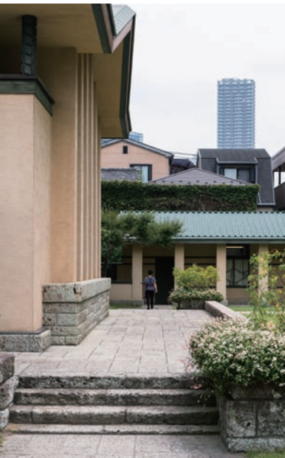
改修前、建物外側の大谷石は酸性雨や歩行による摩耗によって、目地が浮き出ているような状態だった。修復時には、薬剤による石の摩耗や変質の対策が取られた。
