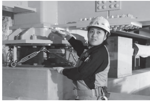
右/入社のきっかけにもなった免震装置(写真は積層ゴム支承)。九州支店の新社屋にも導入されている。 左/昨年行われた「けんせつ小町活躍現場見学会」。参加した子供たちは木枠に自分でデザインしたモザイクタイルを貼り付け、見学会の思い出として持ち帰った。
