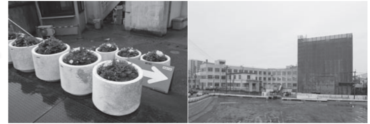
右/北九州市八幡にある新社屋の現場。背後に写る現在の九州支店は1950(昭和25)年に建てられたもの。左/緑化運動の一環として設置した現場入口の植栽。
