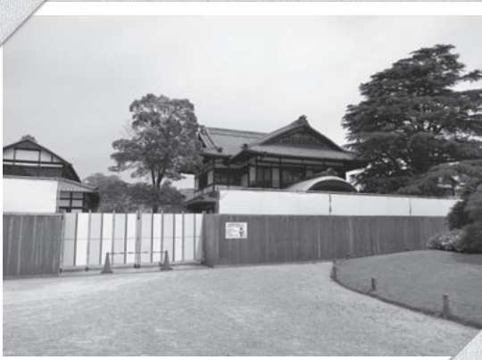
工事中の商工奨励館（2015年5月7日撮影）
