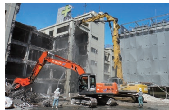
上／Ⅰ期棟は先行して引渡しし、仮使用されている。また、2方向避難を満たすために仮設の階段を設置している。 中／Ⅰ期工事。既存の第2駐車場を掘削し基礎を築く（提供：㈱松村組）。 下／Ⅱ期工事で既存のC、E棟を解体。第1駐車場の敷地と合わせて新築する。
