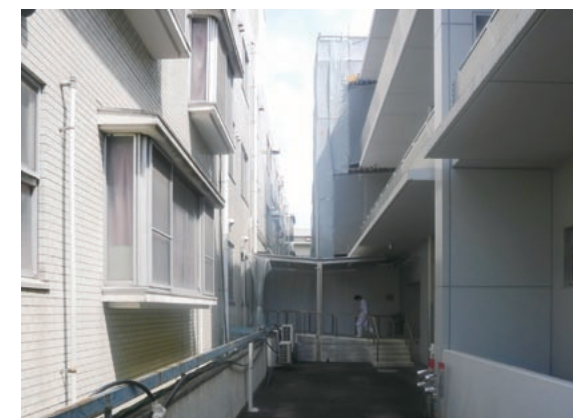
既存のB棟（左）とⅠ期棟（右）を結ぶ仮設の連絡通路。通路の向こう側はⅡ期工事中。全体が竣工すると連絡通路は不要になる（提供：（株）松村組）。
