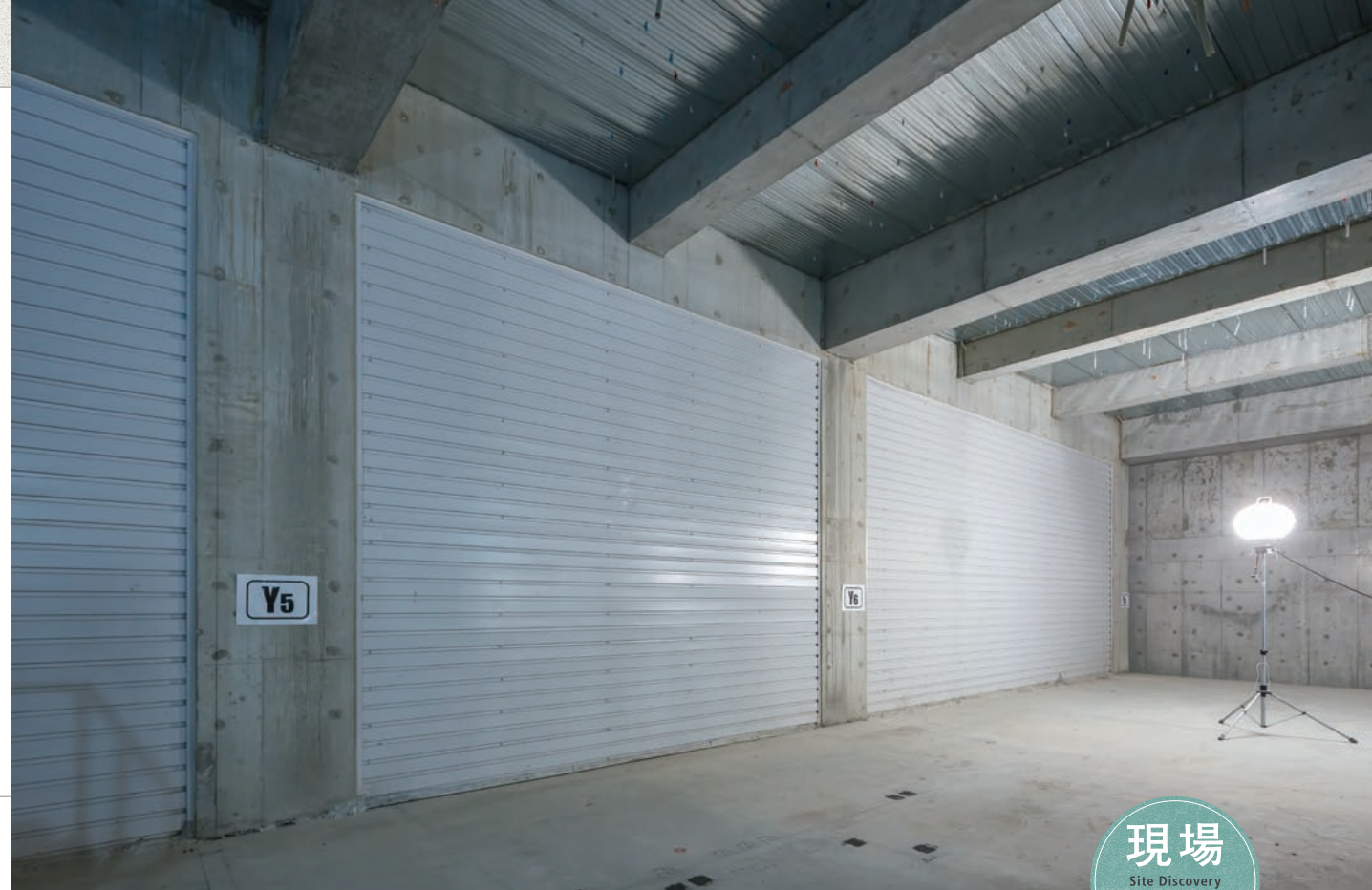
Ⅰ期棟の外壁にⅡ期工事で増築した状況。壁の向こう側はⅠ期棟ですすでに供用されており、手前のⅡ期工事を仕上げるときに壁を外す。
