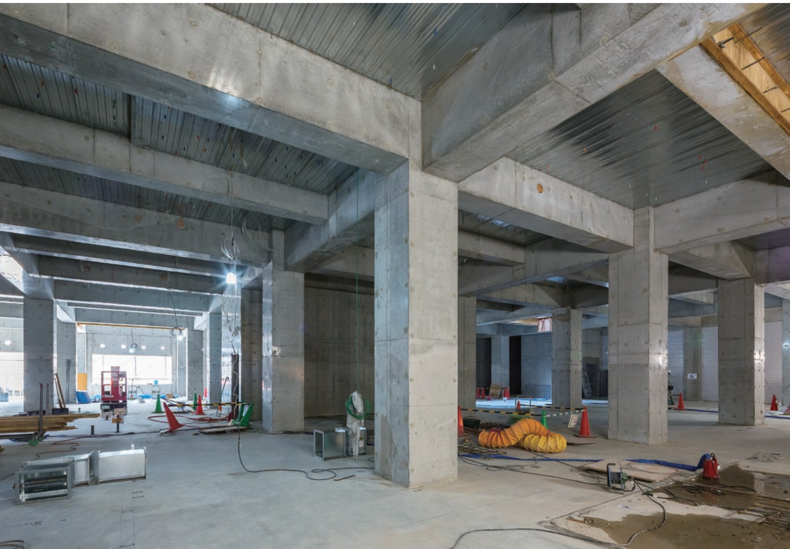
Ⅱ期工事の躯体工事を完了した地下1階。本院は将来のレイアウト変更に対応しやすいように、柱梁で地震力を負担する純ラーメン構造を採用。耐震壁を用いないため空間の自由度が高い。
