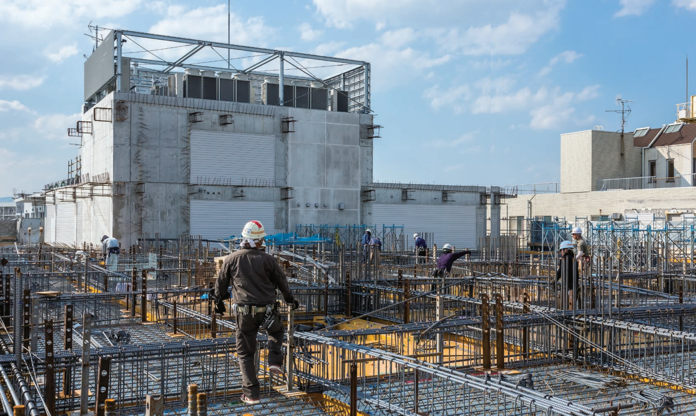
本院改築工事のⅡ期工事が進む現場。左の建物は昨年5月にできたⅠ期棟で、内部はすでに使用されている。梁の鉄筋が突き出している外壁面でⅡ期工事部分と接続する。右奥は工事中も診療に使われている既存のB棟で、Ⅲ期工事で解体される。
