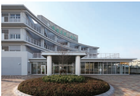
本院から500mほど東の敷地に新築された東香里第二病院。平成27年2月に竣工し、本院の機能の一部を移転した。
