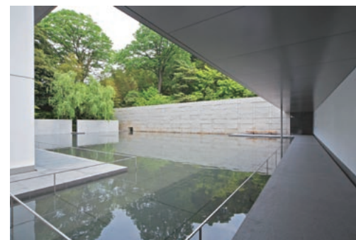
上／内部回廊。玄関棟から展示棟へ導く。玄関の庭が配されている。 下／外部回廊。展示棟から思索空間棟へ導く。水鏡の庭が配されている。
