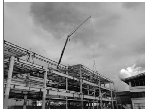
国際ターミナル拡張部鉄骨工事状況
