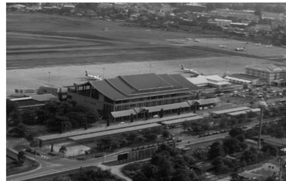
既設空港ターミナルビル全景
