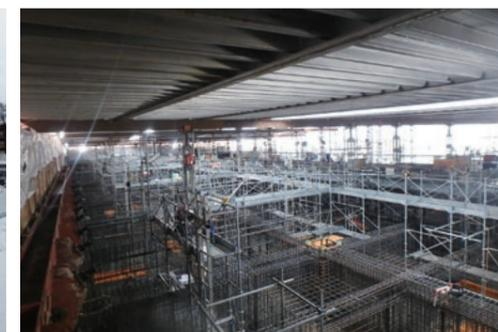
パネルで覆われた現場。天井部に設けた開口からクレーンで吊り上げた資材を搬入する。(提供：岩田地崎建設(株))
