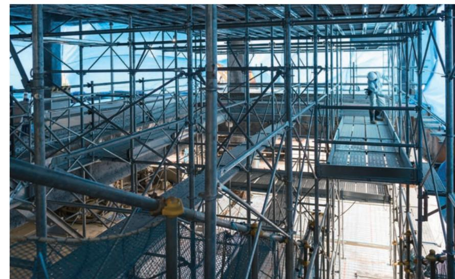
仮設足場には若手の提案で新型の資材を採用した。踏板の頭上に通を妨げる補強材がなく、高さも従来のものよりも高いためスムーズに作業ができるようになった。
