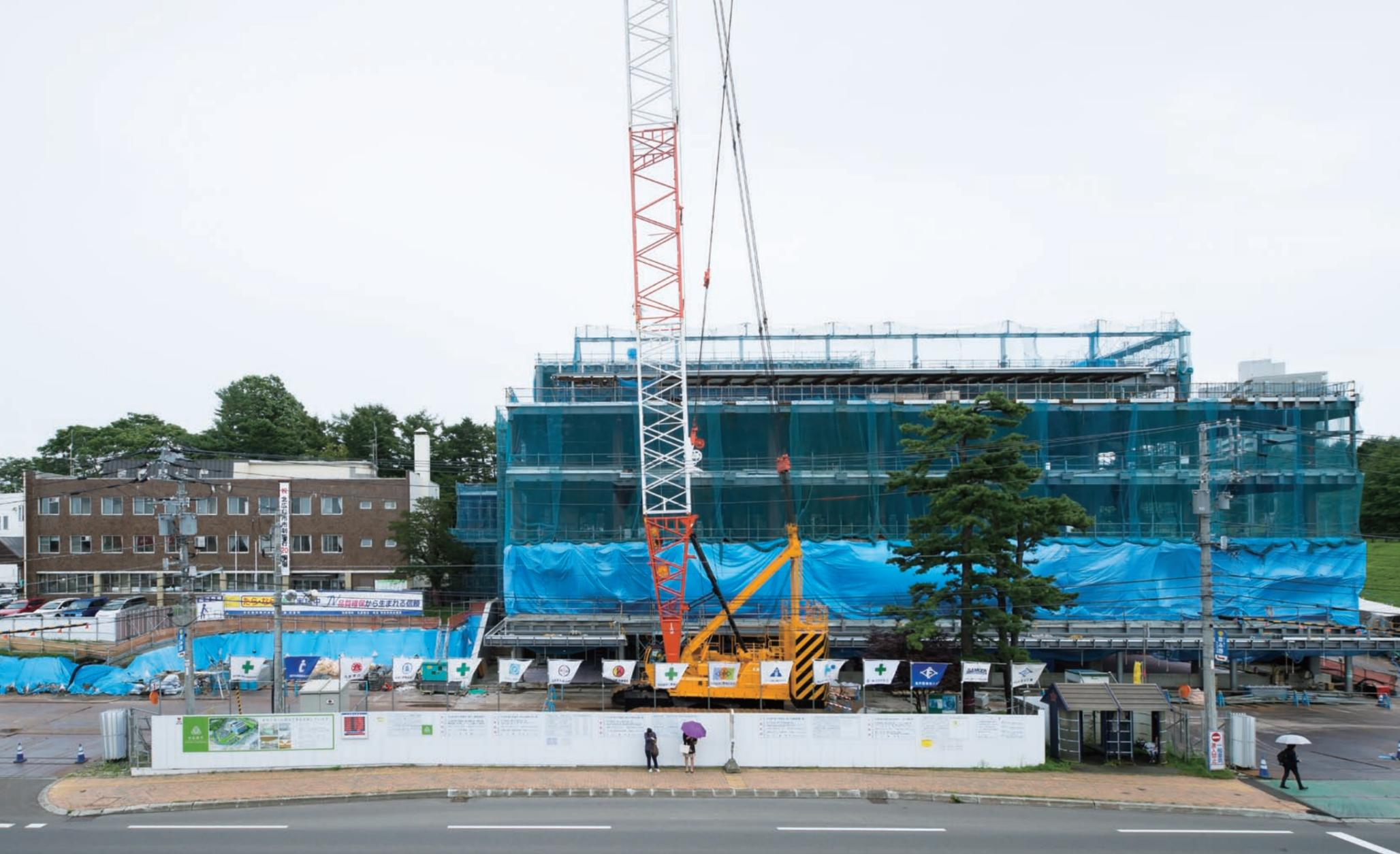
現場の背後にも既存建物があるので土留めをして本工事を着工した。この夏までに鉄骨建て方と床コンクリート打設が完了。PC版を設置する外装工事が本格化している。左奥に見える現庁舎を往来する来庁者、職員の安全確保が最重要課題になる。
