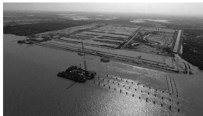
鋼管杭の打設状況
