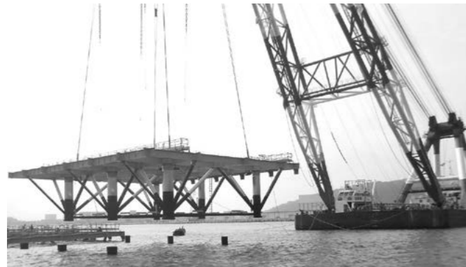
ジャケットの据付状況(当社の国内工事での実施例)
