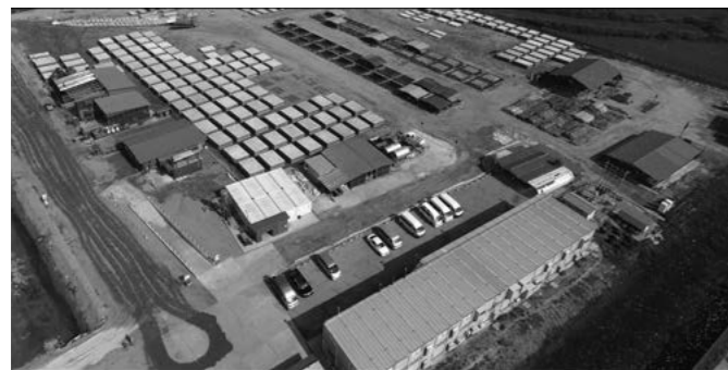
プレキャストスラブの製作仮置き状況(右下の建物は現場事務所)
