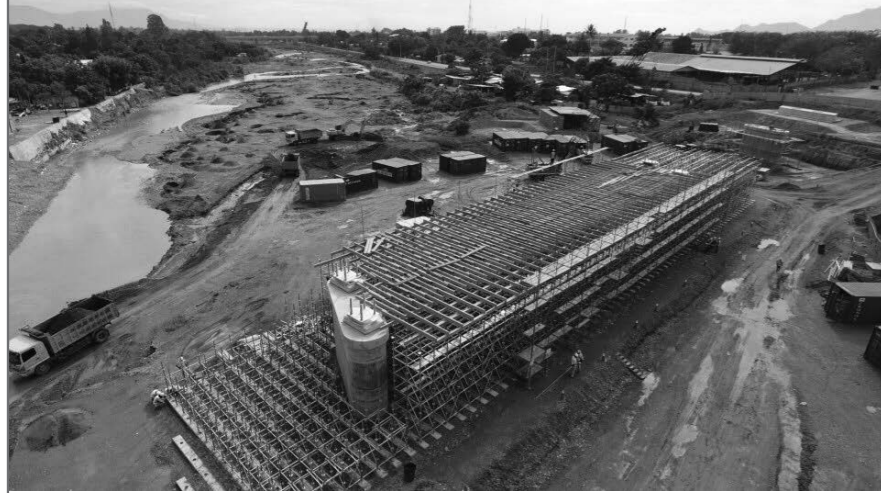
橋梁工事施工状況
