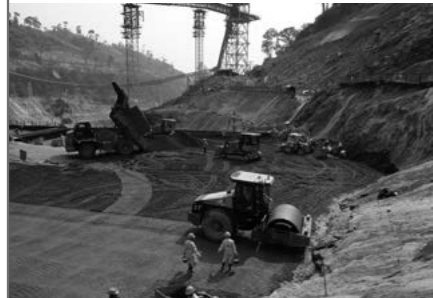
RCC打設状況
