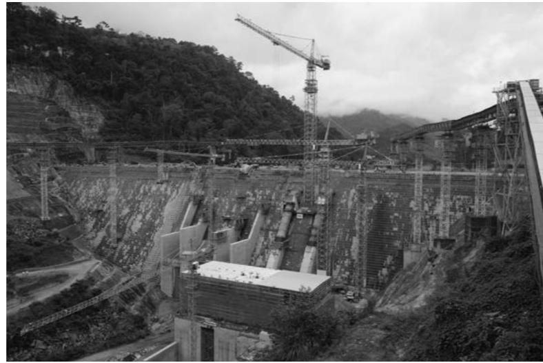
メインダムの全景。中央手前は発電所
