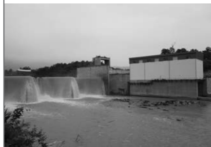
逆調整ダムにおける越流状況。 右は発電所
