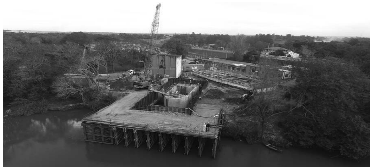
取水棟施設施工中
