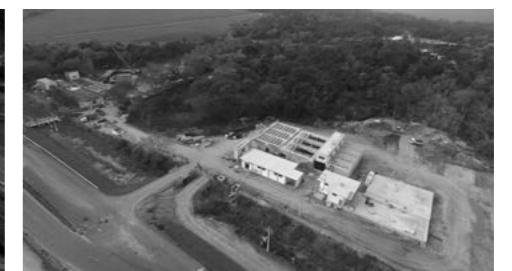
現場サイト全景 (手前：浄水場施設、左奥：取水棟施設)
