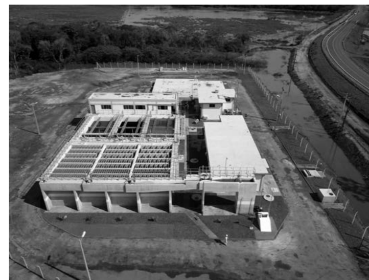
浄水場施設施工完了
