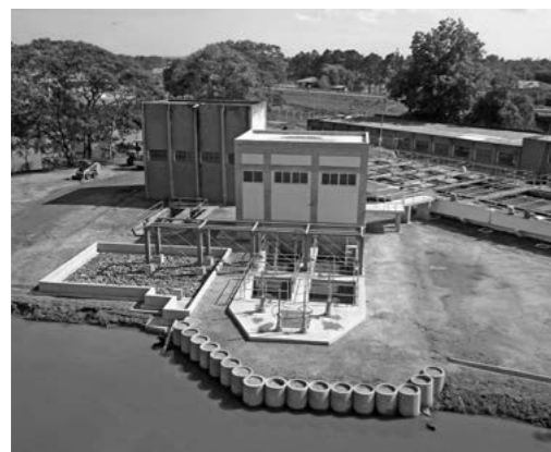
取水棟施設施工完了
