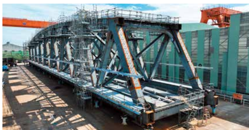
大阪工場で作られた橋梁部材の仮組み状況。部材は現場に搬出する前にヤード内で仮組みされ、詳細な確認作業が行われる。パーツの製作にかかった技能者が場内で完成形に近い状態を体感できる貴重な機会だ（提供：株式会社横河ブリッジ）
