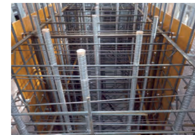
クーリングパイプ設置状況
