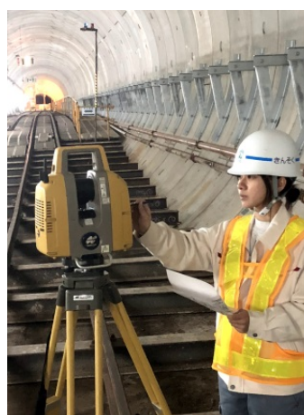
写真1 坑内T L S測量状況
