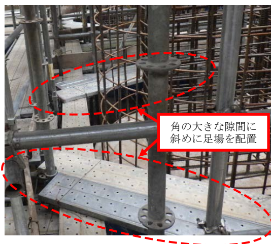
図 12 現場の安全対策（足場配置変更）
