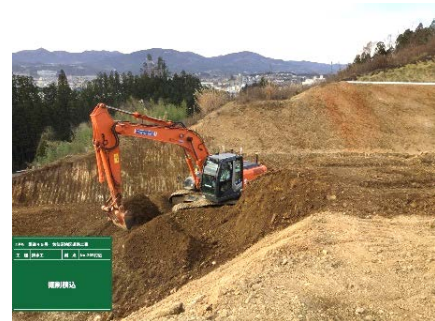
MGバックホウ施工状況
