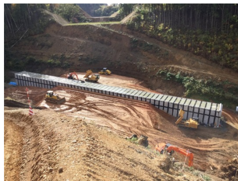
ICT 建機を用いた敷均・転圧状況
