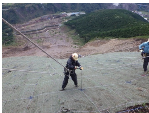
写真.1 探針棒による調査
