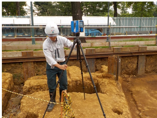
図-1 点群計測状況
