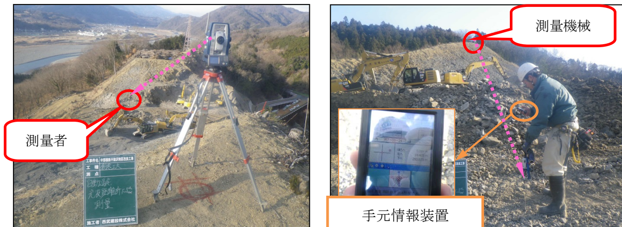
写真-6 自動追尾型測量機を使用した測量状況
