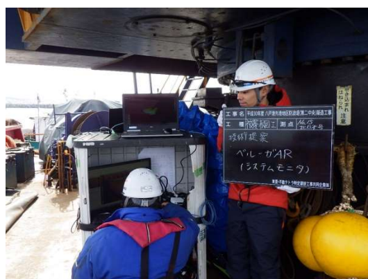
写真 5 水中ソナーによる計測状況
