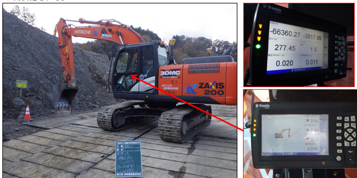
写真-7 マシンコントロールバックホウ施工状況
