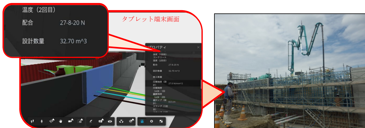
写真-1 タブレットを用いた施工数量等の確認
