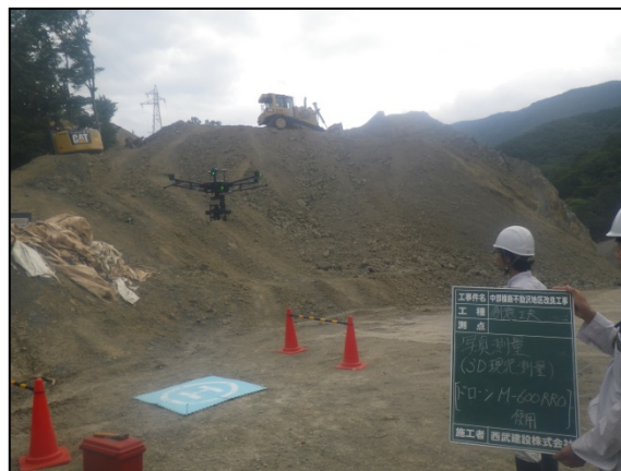
写真-2 UAV 撮影状況
