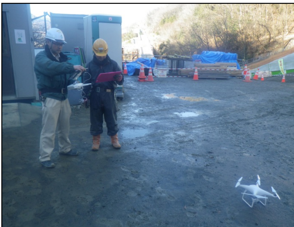
写真-4 UAV 操作状況
