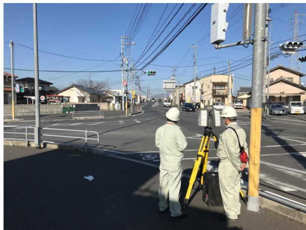
写真－1 3次元計測状況
