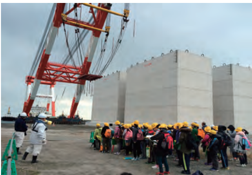
小学生対象工事見学会
