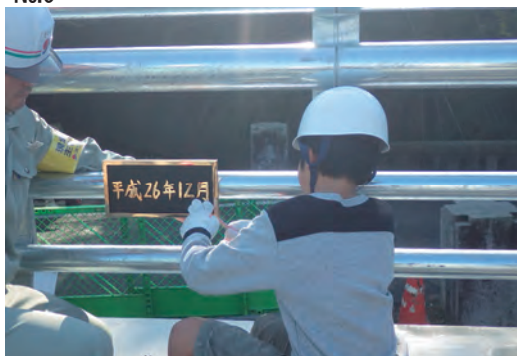
橋名板の取付状況（瀧ノ本橋）
