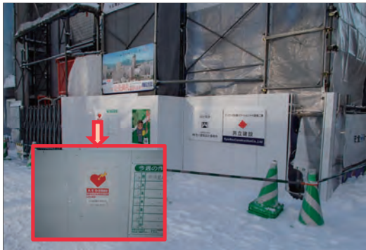
現場事務所へAEDの設置活動
