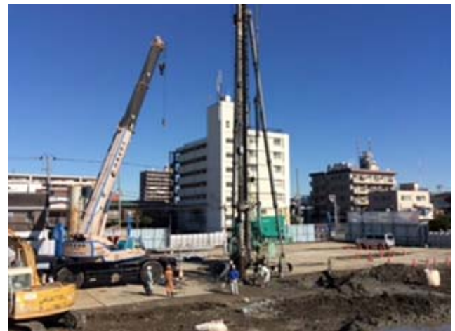
写真-4.2 試験杭の施工状況
