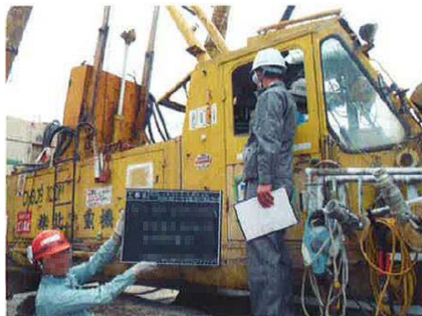
写真-4.4 支持層確認時の立会いの様子
