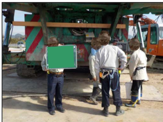
杭打ち工事現場 WEBカメラによる映像・写真撮影
