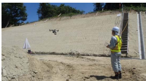
図-2 UAV 計測中の状況
