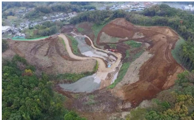
写真-1 厚木森の里施工エリア空撮
