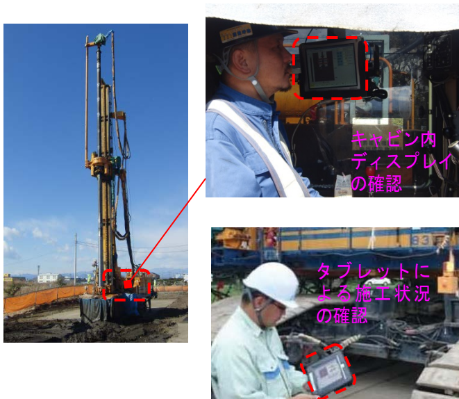
図-1 施工時のディスプレイ確認
