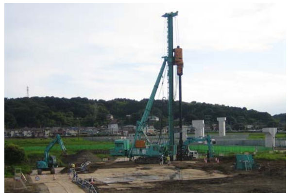
図-1 地盤改良施工状況
