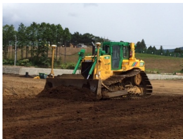
ブルドーザ (マシンコントロール)
