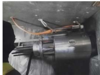
写真-4 ジャッキ据え付け状況
