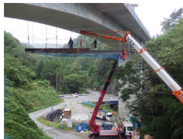
写真-1 施工状況
