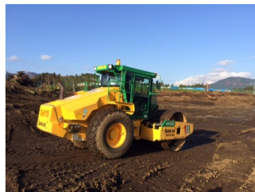
振動ローラ (転圧管理システム)
