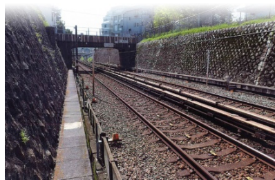
(施工前現場状況)
