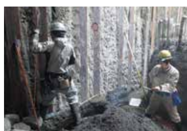
現場にて接地 ※ 工事確認中。現在はまだ掘削した地下での工事段階です。
