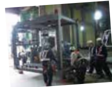
大型機器は一回では入りきらないので何度も分割して搬入し、組み立てて据え付けます。
