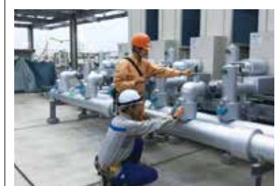
試運転調整前の最終確認！ 地味ですが大事な作業です！
