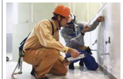
器具付け前の寸法確認です！ 後戻りがないように現場で細かくチェックします！
