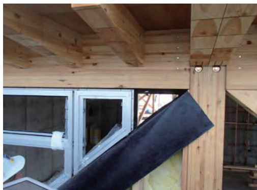
写真-9 防水テープ施工
