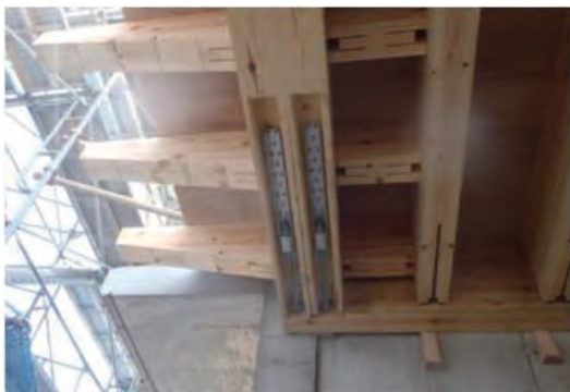
写真-1 シークホールダウンボルト接合（構造梁下側）
