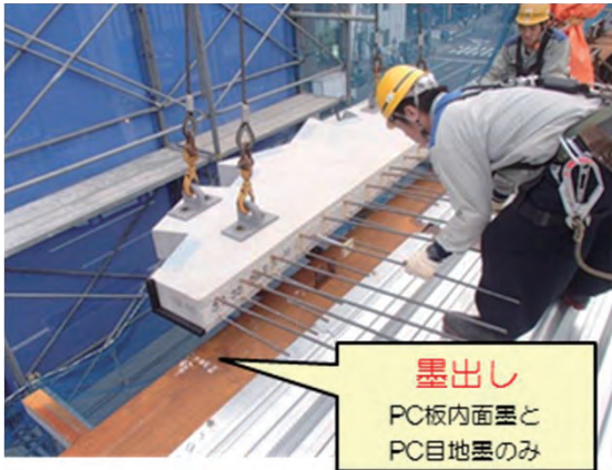
写真6 床端部PCa取付作業状況
