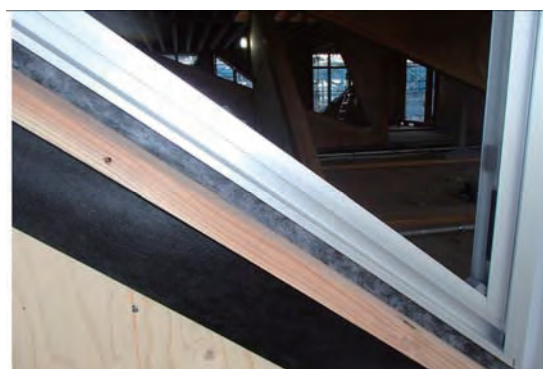
写真-10 水切り下地・合板貼り
