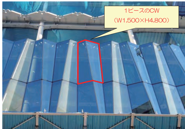
写真2 CW取付状況
