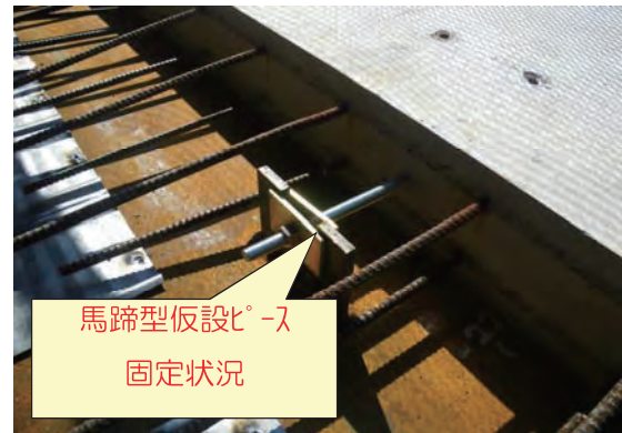
写真5 取付ピース固定状況
