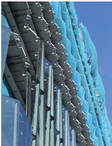
写真10 スラブ端部PCaに取付状況
