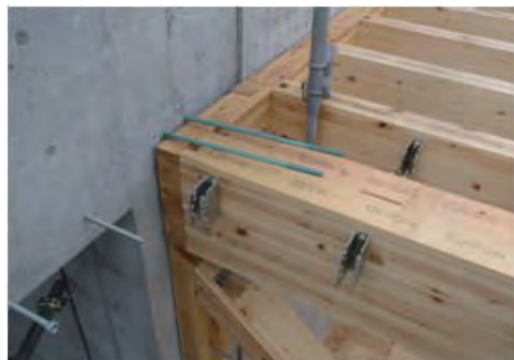
写真-2 シークホールダウンボルト接合（構造梁上側）
