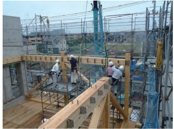
写真-6 木軸建て方状況
