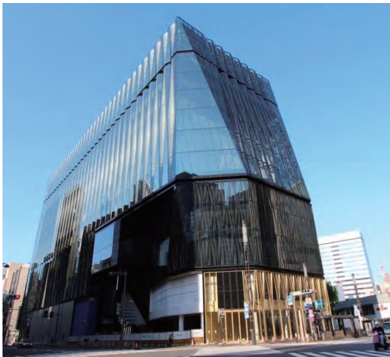
写真12 外壁CW取り付け完了外観
