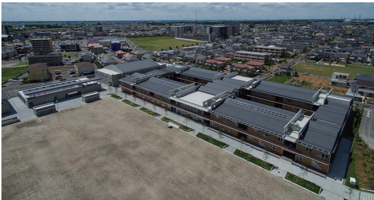
写真－16 竣工写真①
