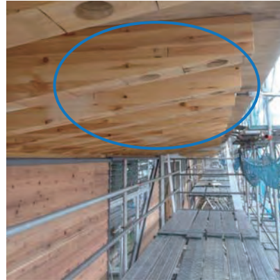
写真-15 手摺受け梁 (木軸)
