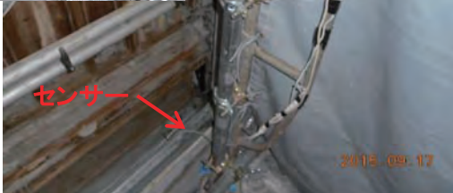
写真-1 屋上防水撤去部センサー
