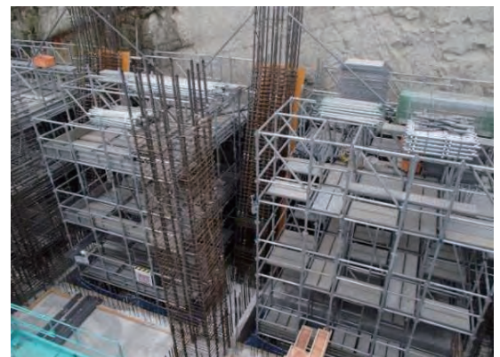
写真 2-2 オーバーハングした柱の施工状況
