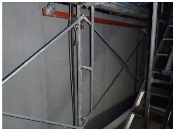
写真-9 内部 ECP 板の状況
