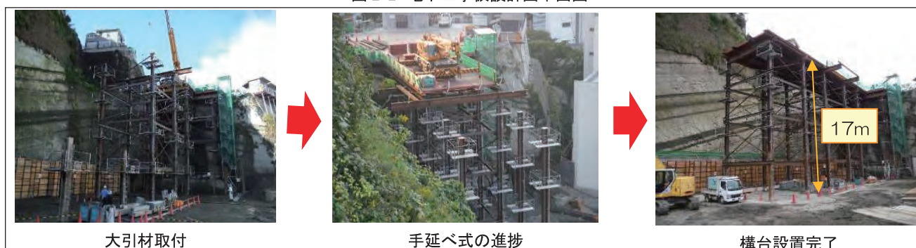
図 2-3 構台の架設状況
