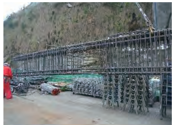
写真 2-1 梁鉄筋地組状況
