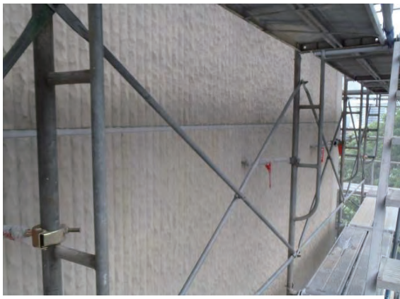
写真-11 PCa 壁面状況
