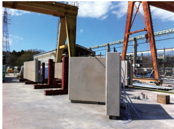
写真-8 PC工場での吸水防止剤塗布完了後仮置き状況
