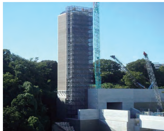
写真-1 換気塔全景
