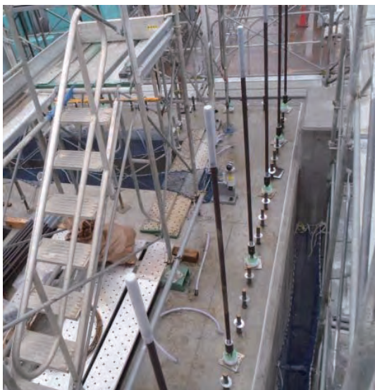
写真-4 接合用鉛直 PC 鋼棒配置状況
