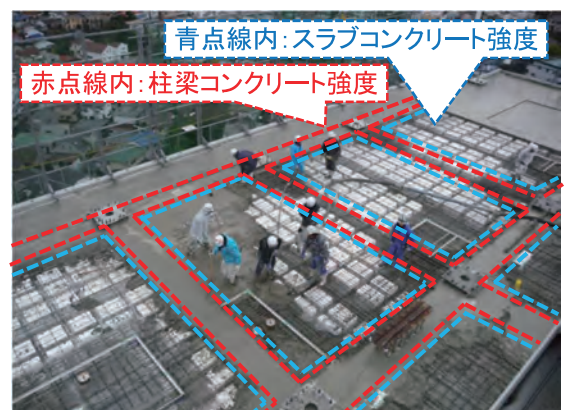
写真 2-3 コンクリート打設状況・強度打ち分け範囲
