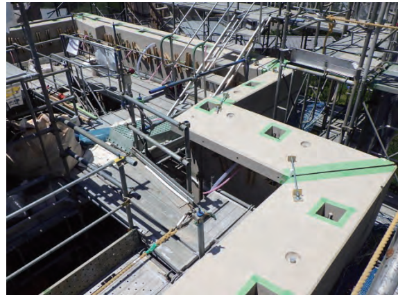
写真-7 最上部 PCa 部材取付状況②
