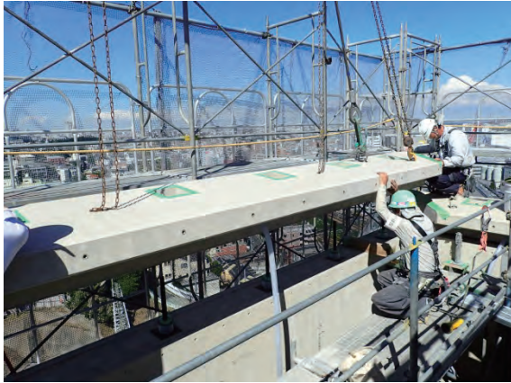
写真-6 最上部 PCa 部材取付状況①
