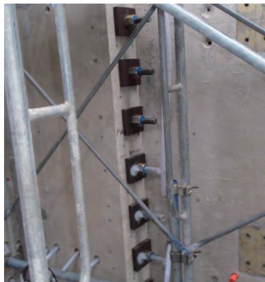
写真-5 接合用水平 PC 鋼棒配置状況
