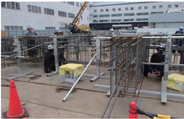
写真－１ 鉄筋先組施工状況
