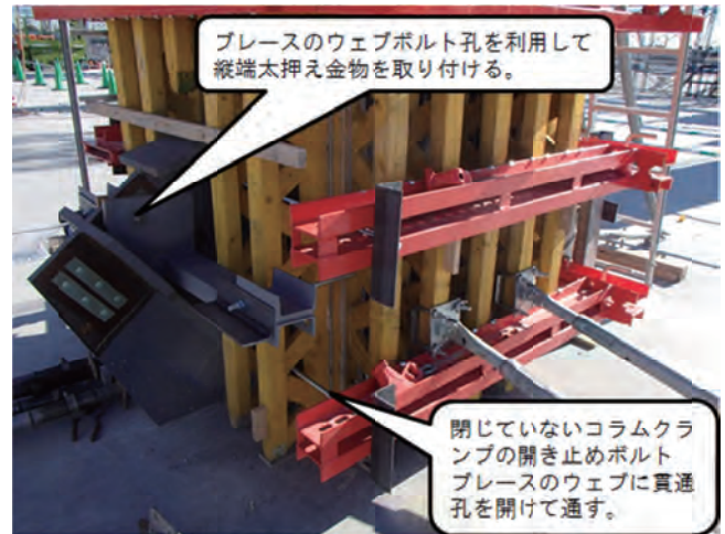
写真－6 システム型枠ブレース取合い(改善後)
