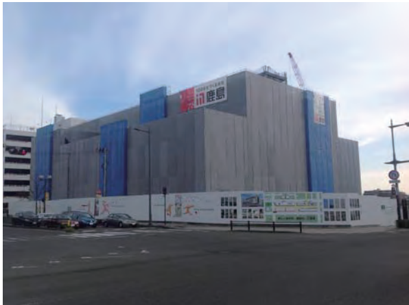
写真一11. 現場仮囲い全景
