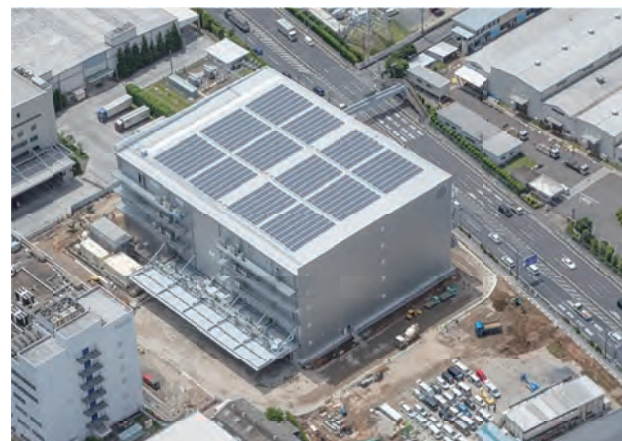
写真-11 作業所全景（2016年6月17日撮影）
