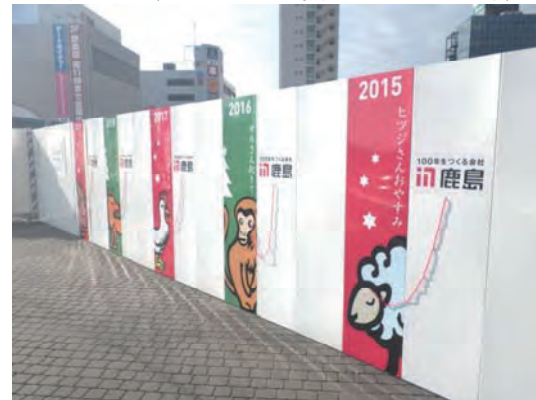
写真一8. 装飾を施した仮囲い
