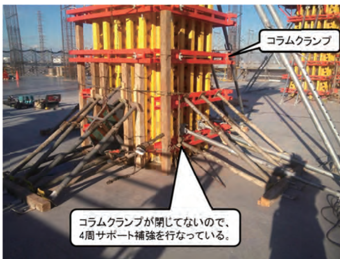
写真－5 システム型枠ブレース取合い(改善前)
