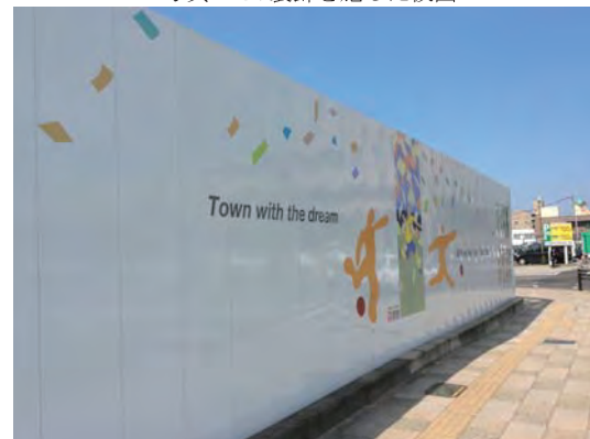
写真一9. 装飾を施した仮囲い
