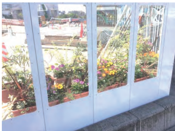
写真一6. 現場のコーナー部のクリアパネルと花壇
