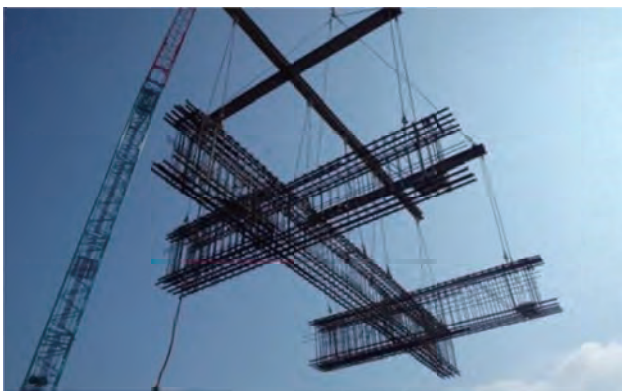
写真－２ 鉄筋先組取付け状況
