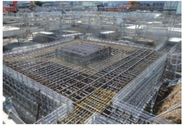
写真－３ ラス型枠施工状況
