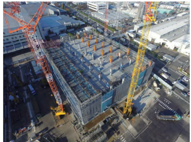
写真－４ 地上躯体施工状況
