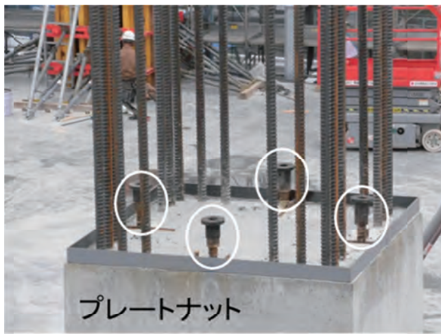
写真-7 柱頭仕口鉄骨取付け前
