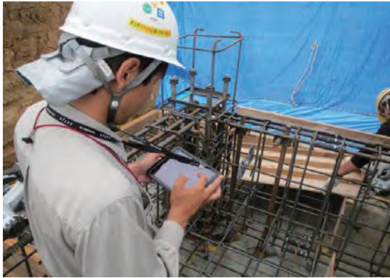
写真—2. 配筋検査状況
