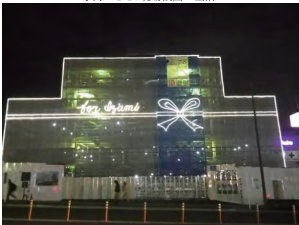
写真一12. 外部足場を用いたイルミネーション
