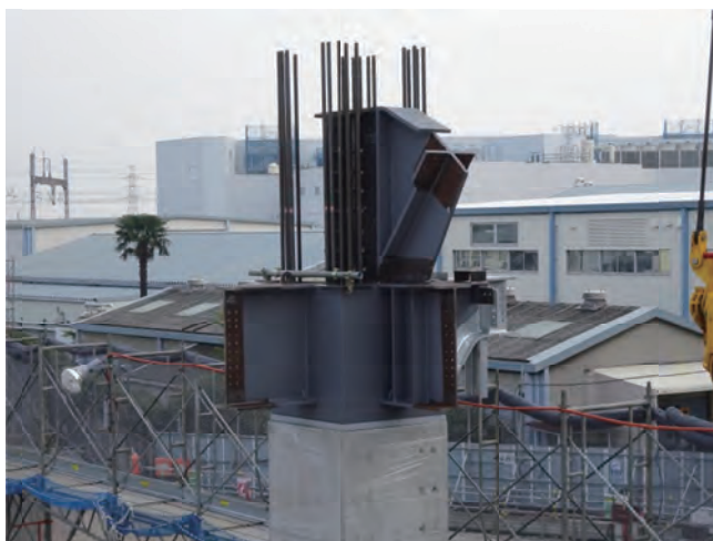
写真-8 柱頭仕口鉄骨取付け後
