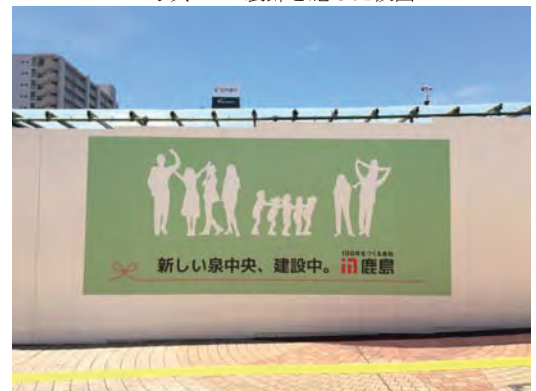
写真一10. 装飾を施した仮囲い
