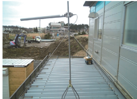
写真-2 受信側アンテナ（指向性）設置例
