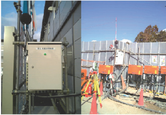
写真-5 騒音・振動計、粉塵計測盤
