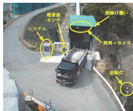
写真-1 現場でのシステムの設置
