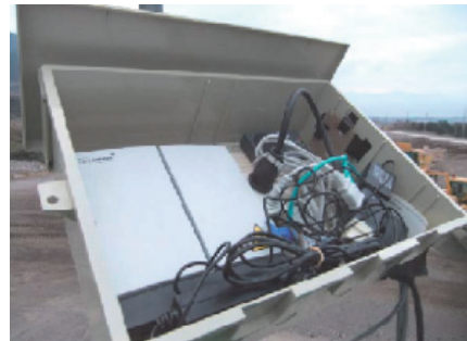
写真-1 衛星通信アンテナ
