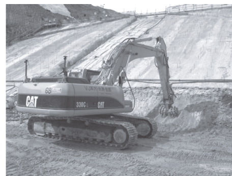
図-6 仕上げ掘削施工状況
