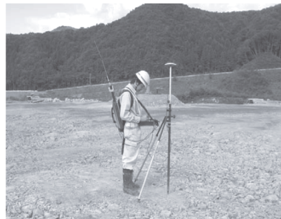
図-2 3D-Navi による測量状況
