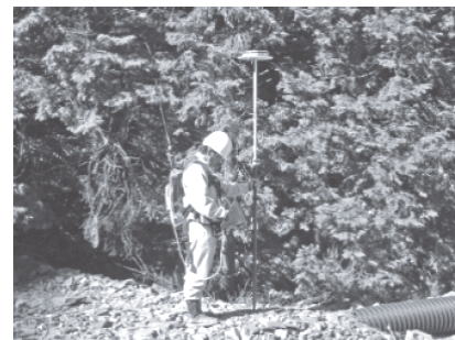
図-5 3D-NAVi による測量状況
