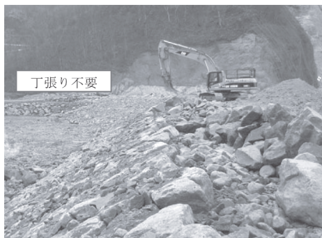
図-5 下流面リップラップ施工状況
