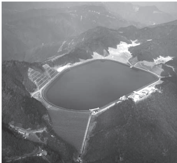
図-1 調整池全景
