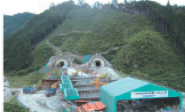
写真-1 鳳来トンネル
