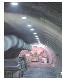
写真-3 坑内のLED照明
