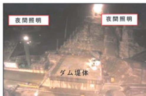
写真-1 ダム夜間照明の事例
