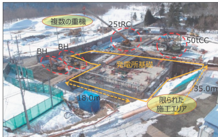
図-2 発電所基礎施工状況
