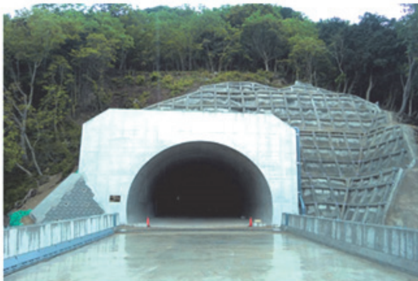
写真-1 十九渎第一トンネル全景
