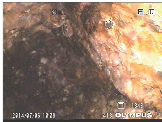
写真-2 DRi スコープにより得られた孔壁画像
