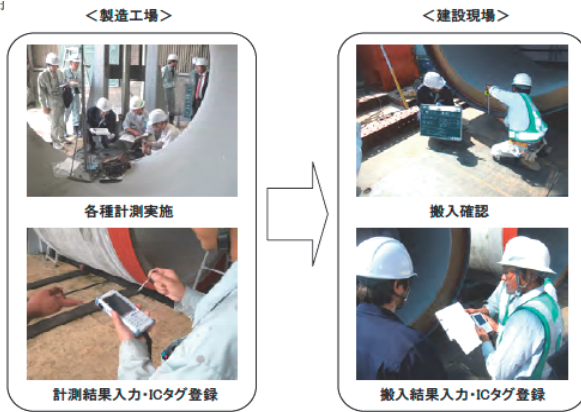
写真-4 IC タグによる品質管理の状況
