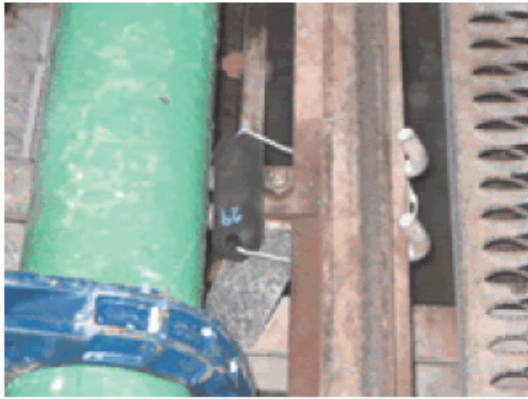
写真-1 レールに取付けた IC タグ設置状況
