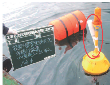
写真-4 浮標灯設置
