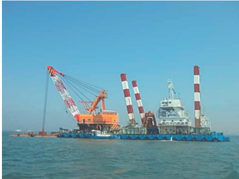
写真-1 浚渫状況
