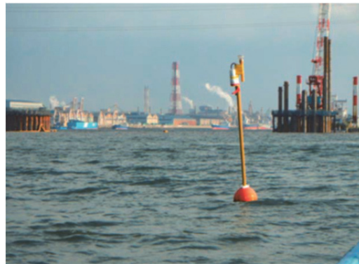
写真-2 通信制御装置の設置状況
