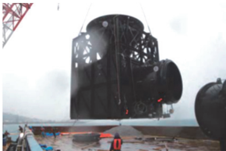
写真-1 取水口J管設置状況
