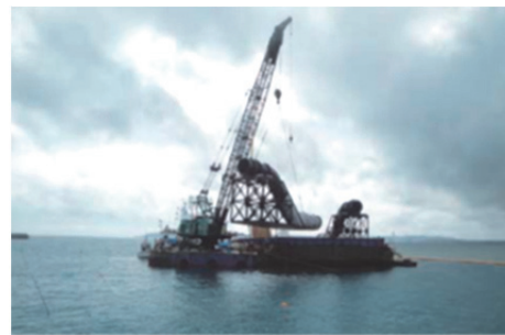
写真-2 放水口設置状況
