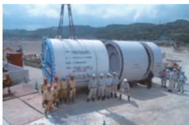
写真-3 推進機全景
