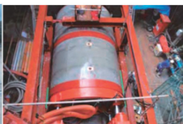
写真-4 掘進状況
