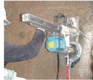
写真-2 コア削孔 (φ42 mm)
