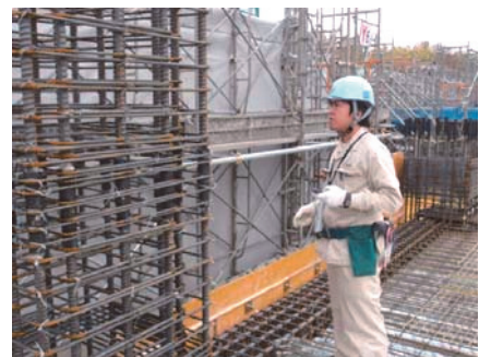
写真-1 鉄筋全数検査の様子
