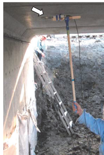
写真-5 施工後のひずみ計測状況
