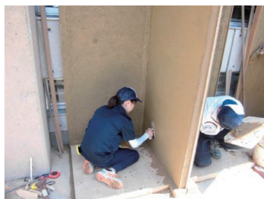
左官施工実習
