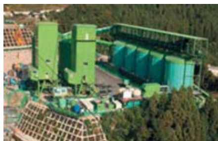
仮設備へのアースカラー塗装
