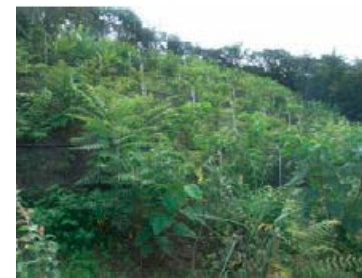
施工1年後の法面状況
