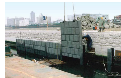
護岸パネルの設置例
