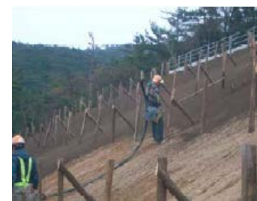
吹きつけ状況
