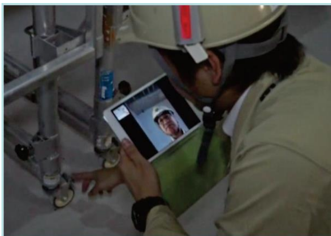
現場事務所から工事現場の状況確認
