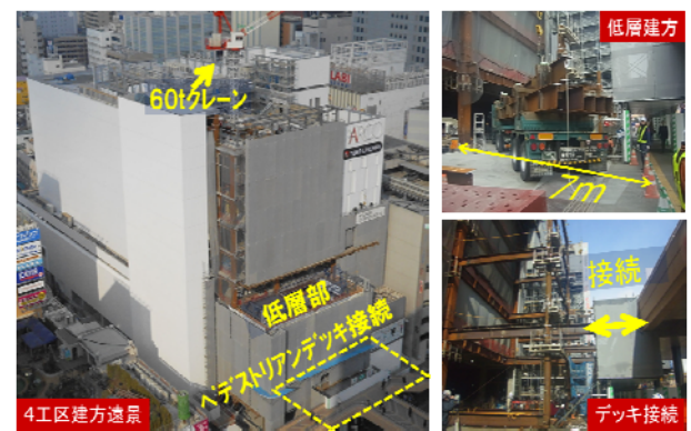
写真-13 4工区鉄骨建方
