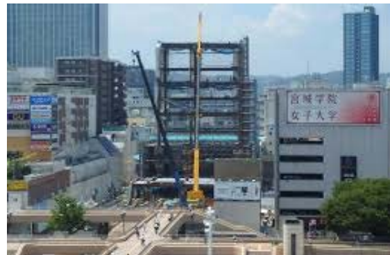
写真-16 無足場工法での現場全景
