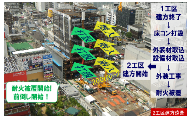
写真-11 2工区鉄骨建方
