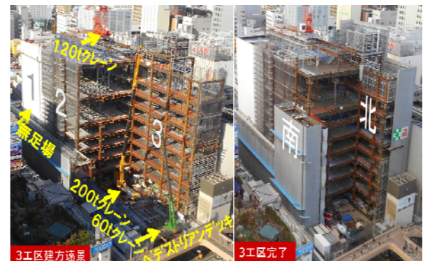
写真-12 3工区鉄骨建方
