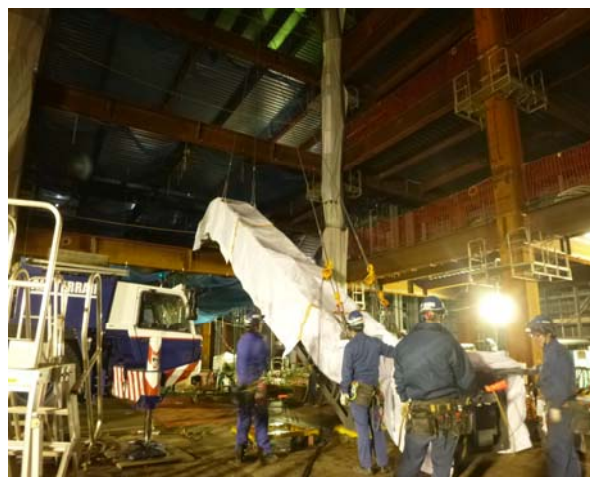
写真－19 エスカレーター先行設置状況
