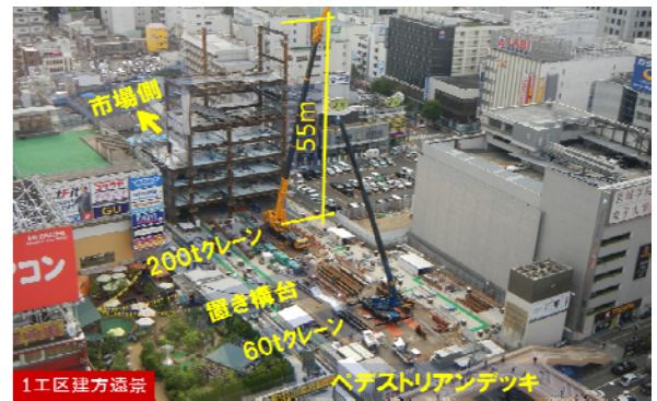
写真-10 1工区鉄骨建方
