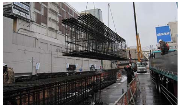
写真一8 工場先組鉄筋搬入状況
