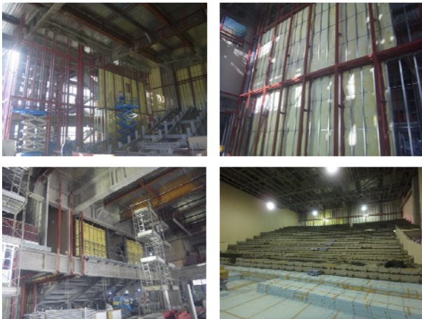
写真一 2 1 シネマ工事状況
