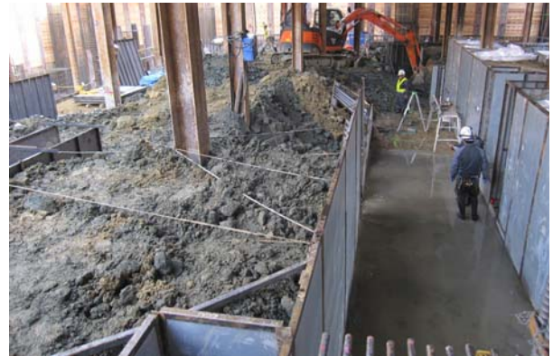
写真一7 鋼製型枠と埋戻し
