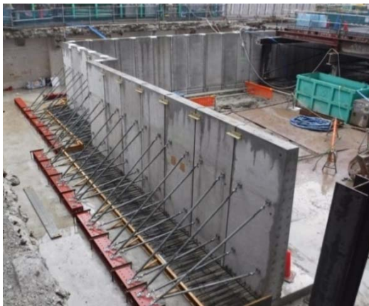
写真-2 外壁PCa設置状況
