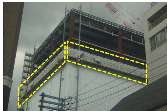
写真-15 外壁施工状況(南西角面)
