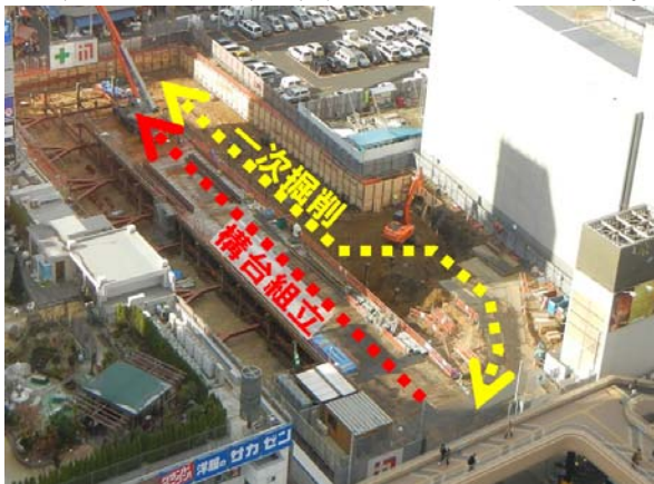
写真一6 掘削工事全景
