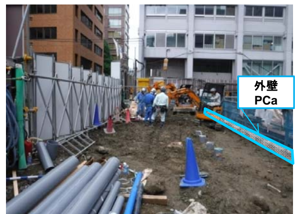
写真-4 外周埋戻し状況 北面
