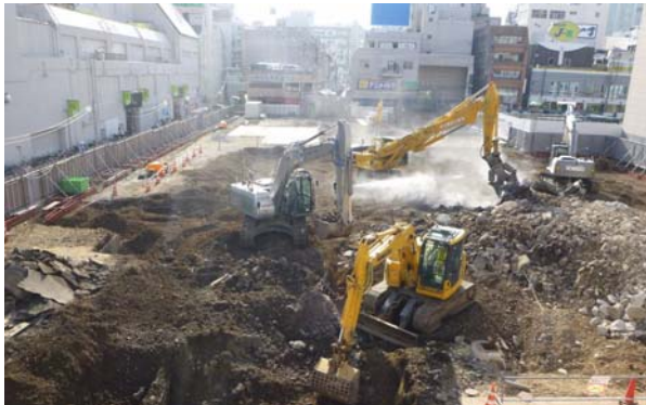
写真—3 既存舗装解体状況
