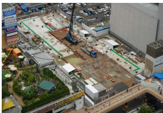
写真-9 置き構台設置状況
