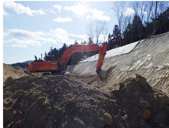
写真4 MG 施工状況
