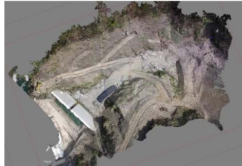
図-2 盛土着手前の点群データ (出来高測量結果)
