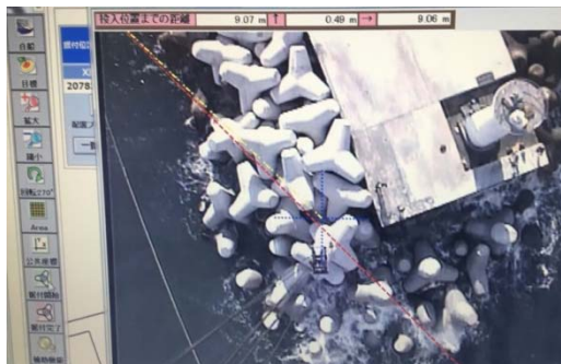
図-8 据付システムモニター画面
