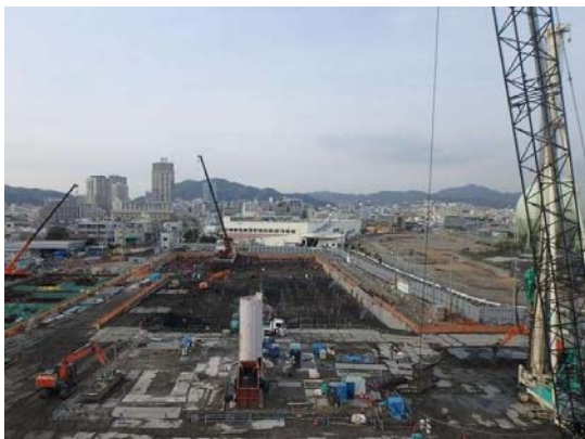
写真-1 現場全景写真
