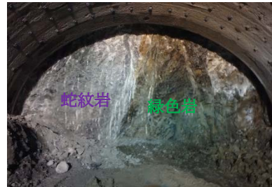
写真-1 軟質な蛇紋岩と硬質な緑色岩からなる切羽状況の一例
