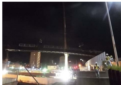
図-3 実際の架設状況
