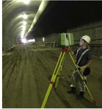
TLS 計測状況
