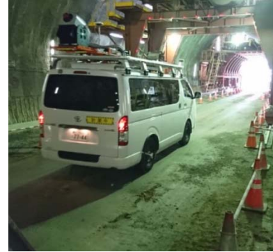
MMS 計測状況
