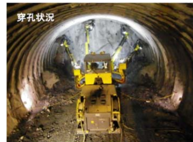
写真-2 コンピュータジャンボによる装薬穿孔状況
