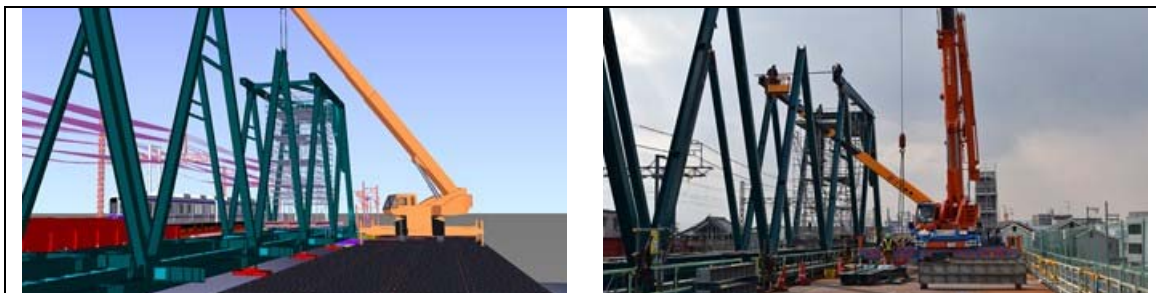
図-2.3D モデルと実際の施工状況の比較
