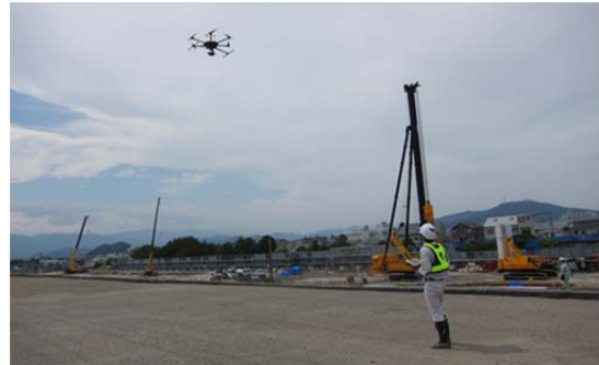
図-3 UAV 測量状況
