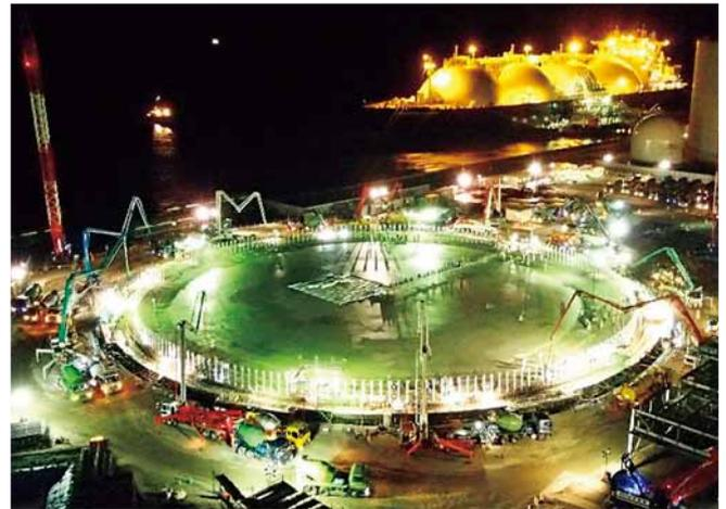
写真-1 基礎版コンクリート打設状況
