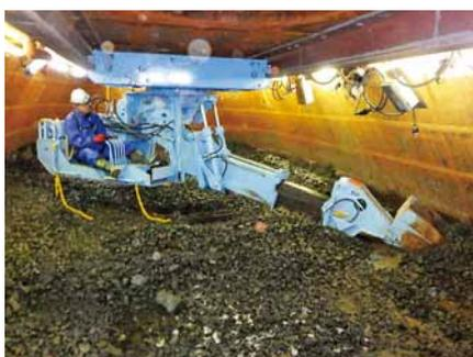
函内でケーソンショベルを直接操作して掘削
