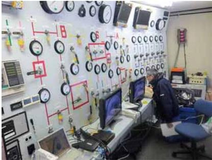
ヘリウム制御室で混合ガスの供給を監視しています。
