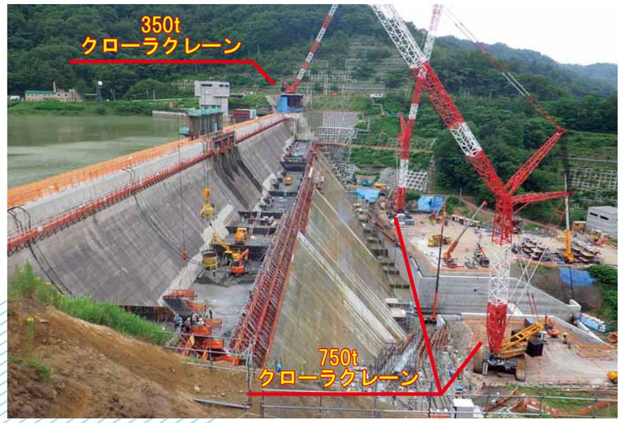
写真-1 堤体コンクリート打設状況
