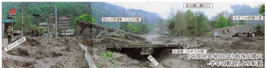
熱泥水により流出し、西山川流路工を塞いだこんぴら橋桁
