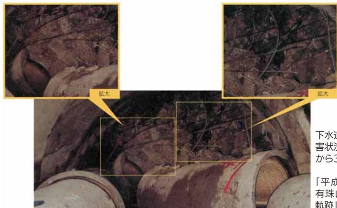
下水道トンネルの被害状況（本町側坑口から347m付近）
