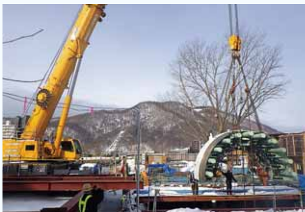
発進立坑の中にマシンの部品を投入
