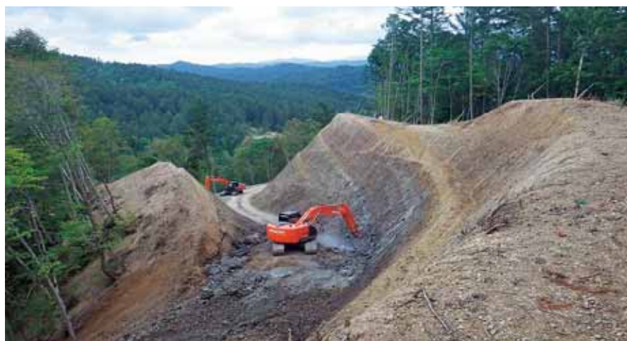
現在の林道工事の様子
