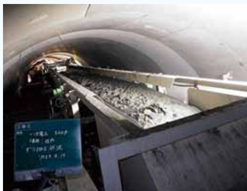
ベルトコンベアで土砂をマシン後方へ
