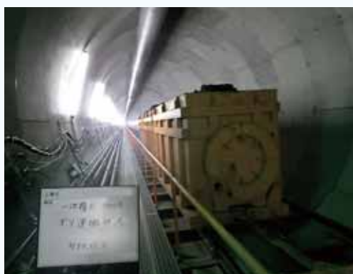
ズリ鋼車で土砂運搬中
