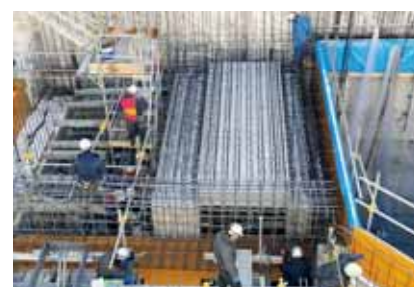
写真-8 ハーフプレキャスト設置状況
