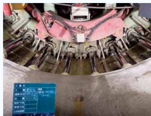
写真奥のシールドマシンと、手前の組み立て済みセグメントの間のジャッキ
