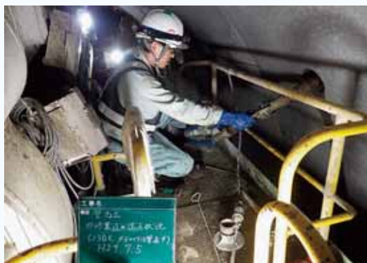
セグメントにはあらかじめ注入用の穴が開いています
