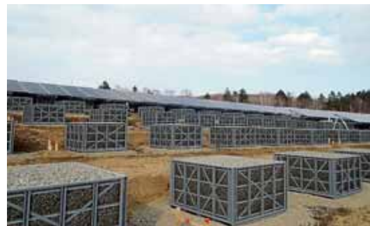
写真-6 かご基礎設置状況
