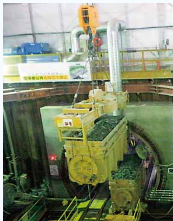
発進立坑でズリ鋼車を引上げ中
