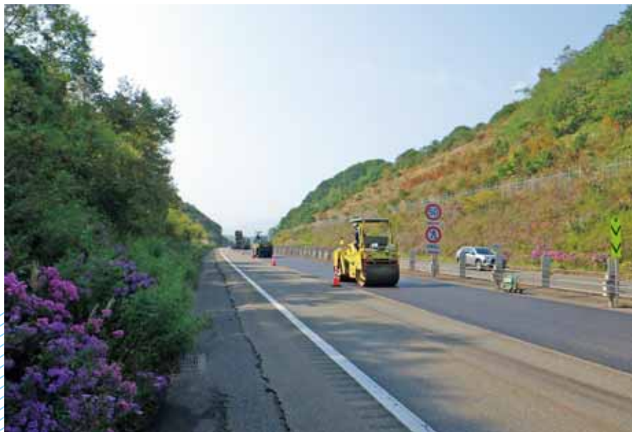
写真-1 切削オーバーレイ施工状況
