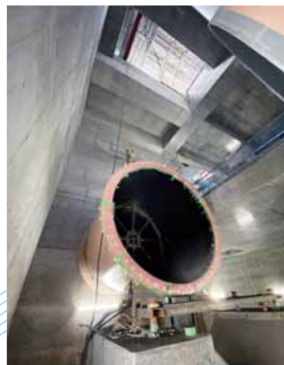
写真-6 プレキャスト下面と水圧鉄管
