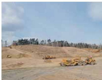
写真-5 K-tec による土工事作業状況
