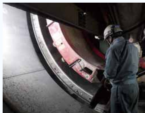
シールドマシンの中で組み立て中
