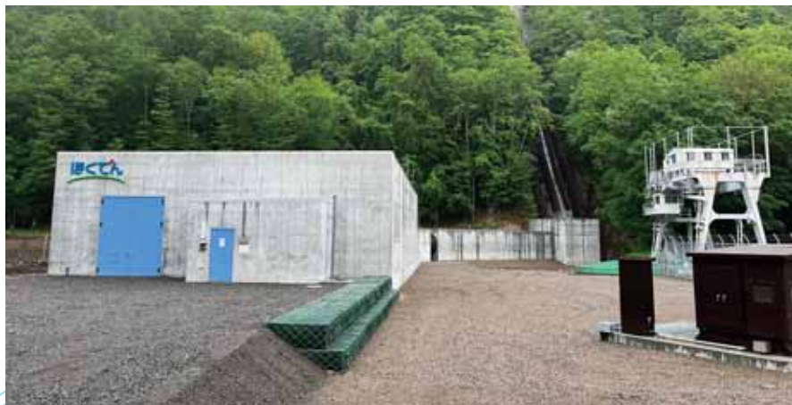
写真-1 発電所全景
