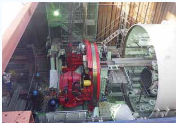
立坑内でマシン組立て
