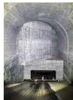
写真-4 放水池内部
