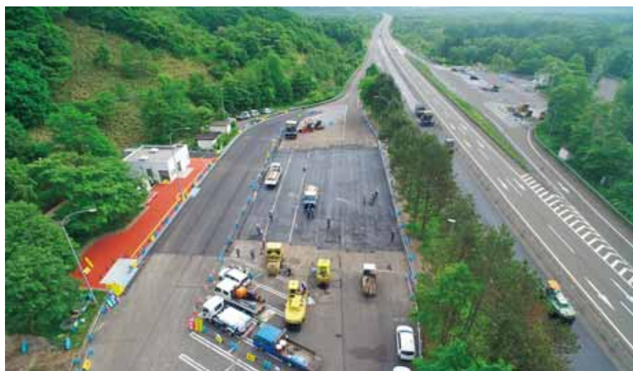
写真-2 萩野PAバリアフリー施工状況
