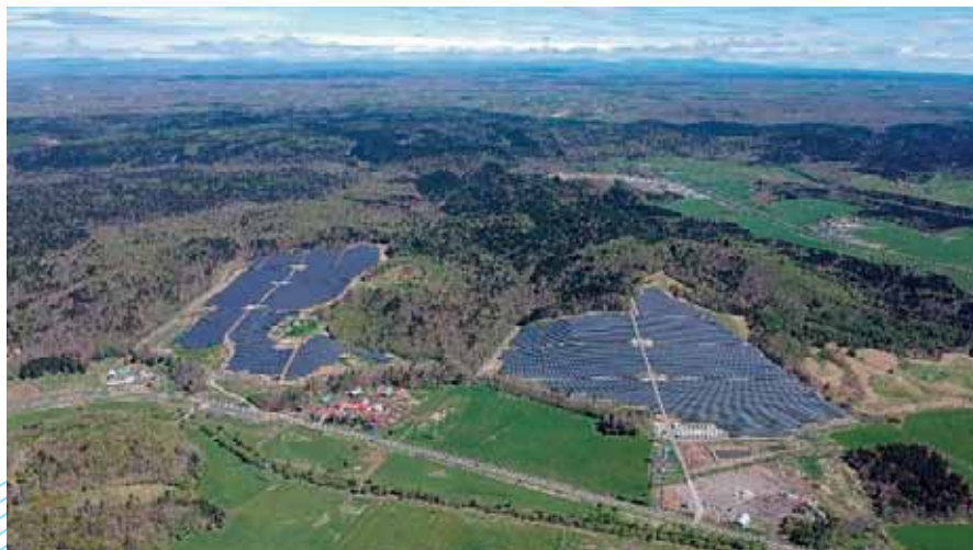
写真-1 工事箇所全景（工事竣工時）
