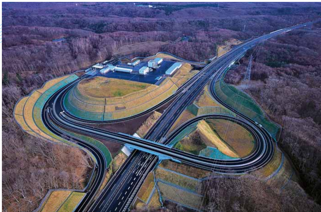
写真-3 苫小牧中央IC完成
