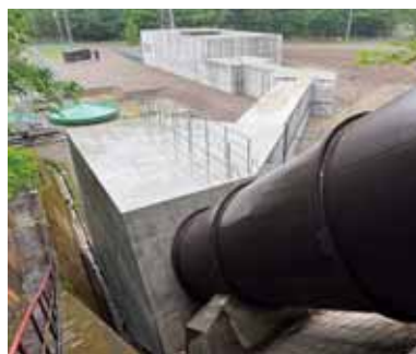
写真-2 発電所全景
