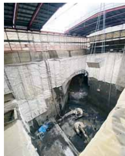
写真-7 発電所掘削状況
