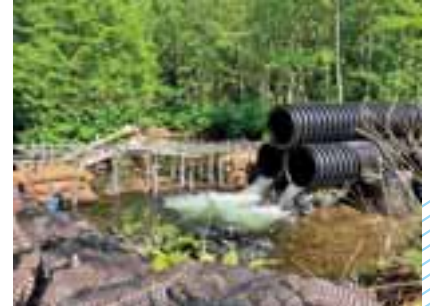
下二股川切回しとバイオログフィルタ・ボトルユニット設置
