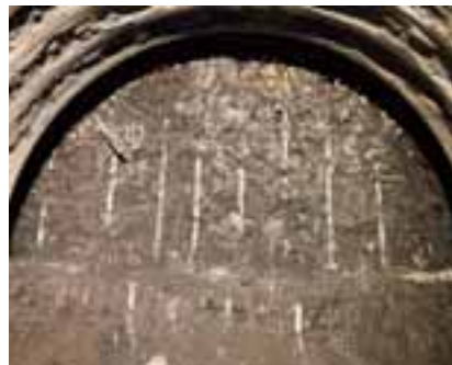
切羽写真(地山改良とAGFの効果を確認できる)
