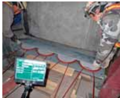
写真-2 施工状況
