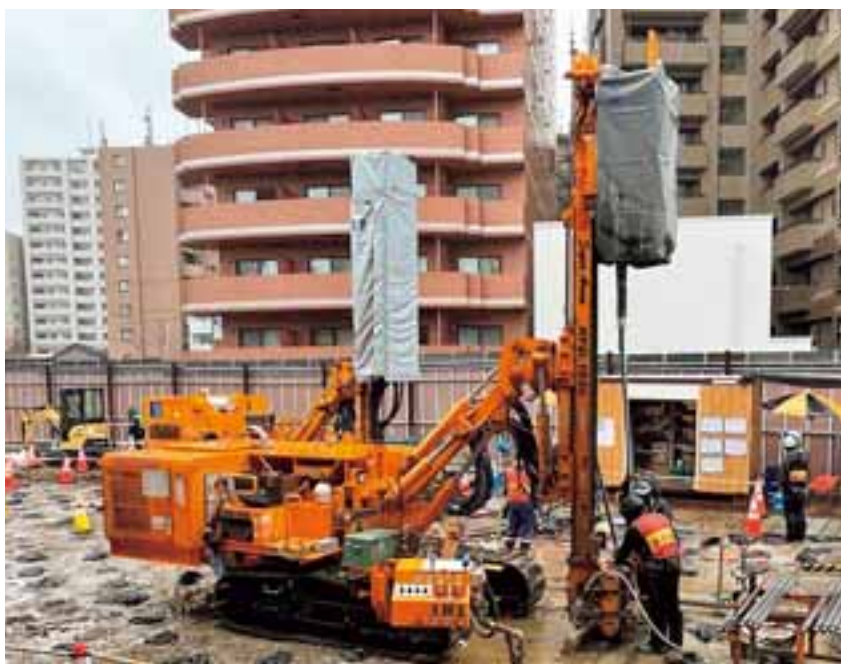
▲地盤改良の作業（桑園工区）
