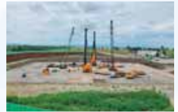
見学ステージ上から現場を一望できる。石狩川の左岸築堤を全段面で開削している
