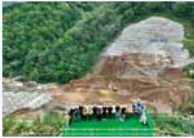
右岸側展望台から掘削箇所を望む
