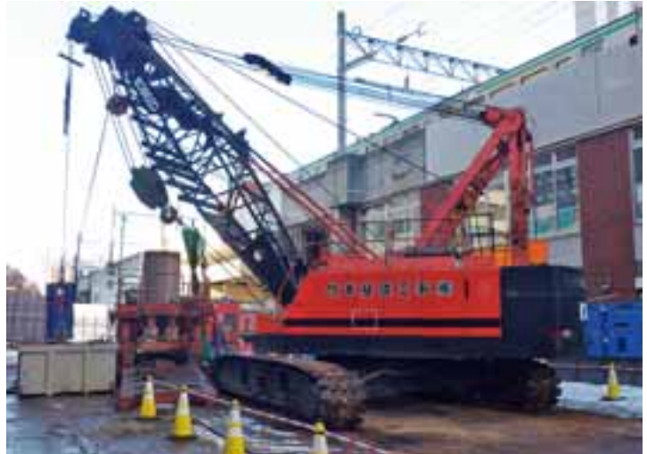
◀全旋回掘削機（桑園工区）
