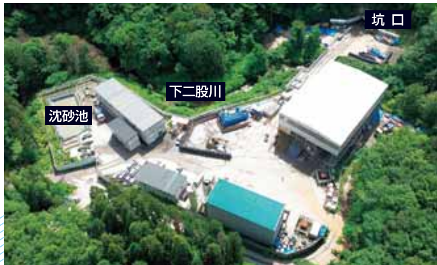
トンネル坑口と仮設ヤード、下二股川
