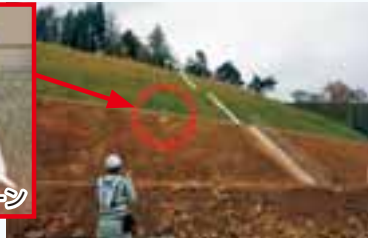
無線遠隔でドローンを操縦して、上空から地形を連続的にスキャン
