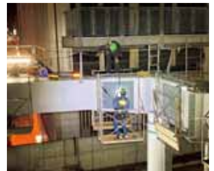
写真-5 トビックを使用したボルト締付作業
