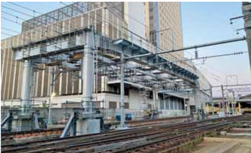
写真-1 [施工状況全景 (東西連絡橋P18~P20)]
