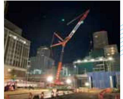
写真-4 550tオールテレンクレーンによる施工状況
