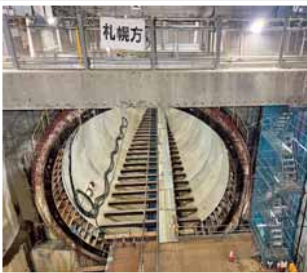
札幌方シールド坑内
