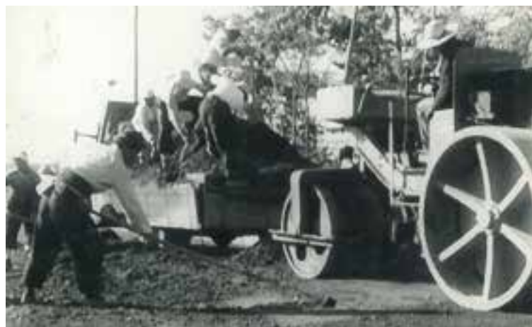
転圧コンクリートの舗設作業状況
