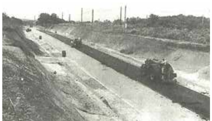
アスファルト舗装転圧状況
