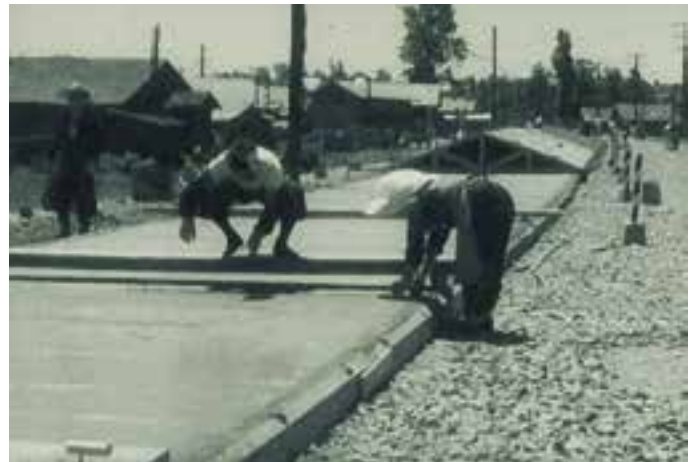
コンクリート舗装仕上げ状況
