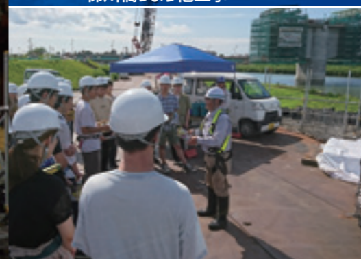
梯川橋りょう他工事
