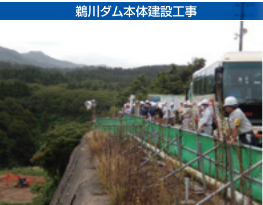
鵜川ダム本体建設工事
