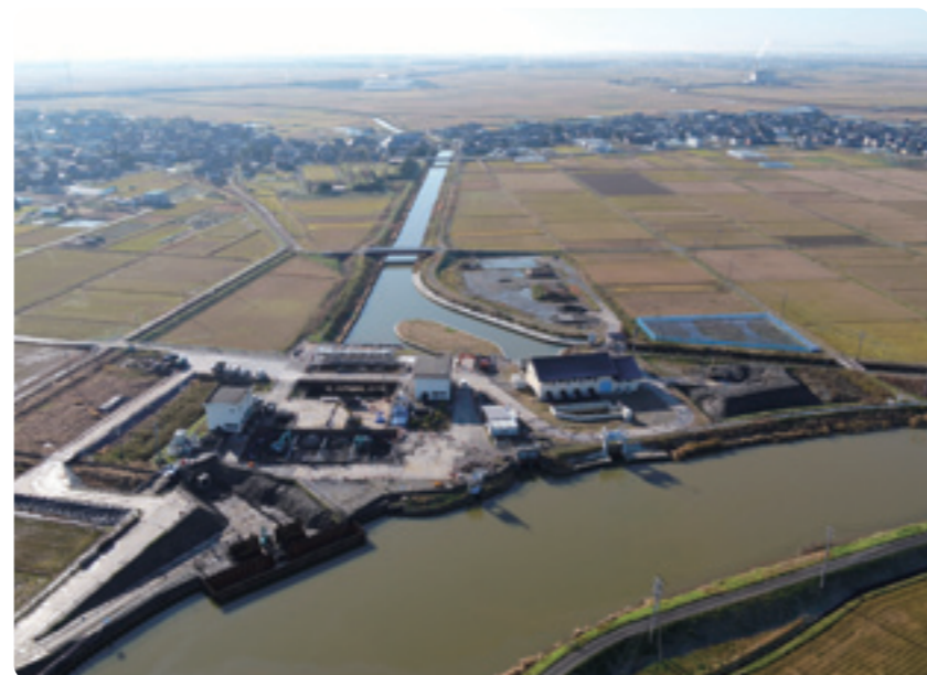
旧木山川排水機場
