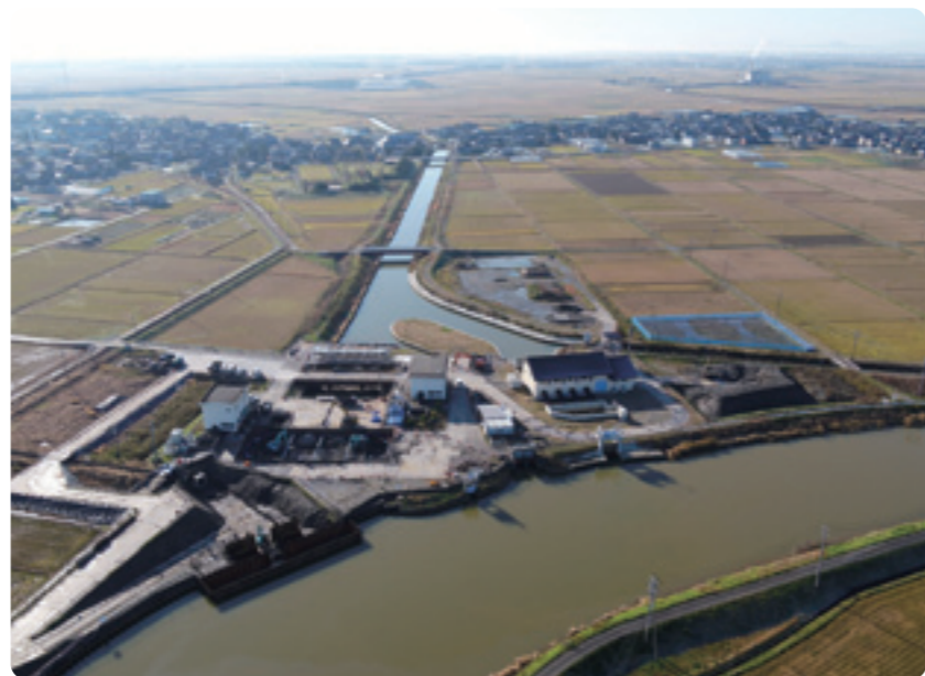
旧木山川排水機場
