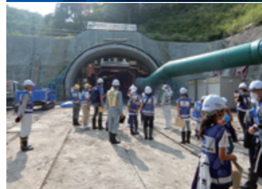
国道8号柏崎トンネル(山岳部)工事
